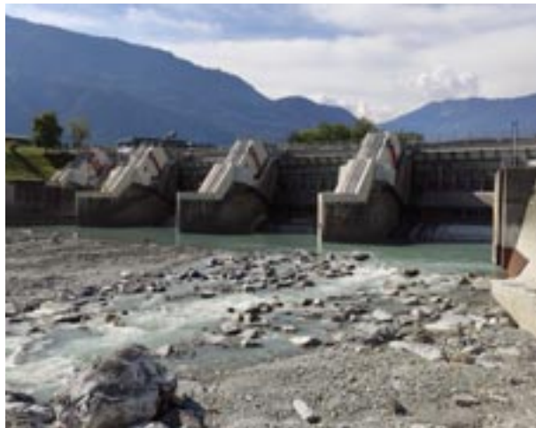
Situazione della centrale di Reichenau a settembre 2022.
