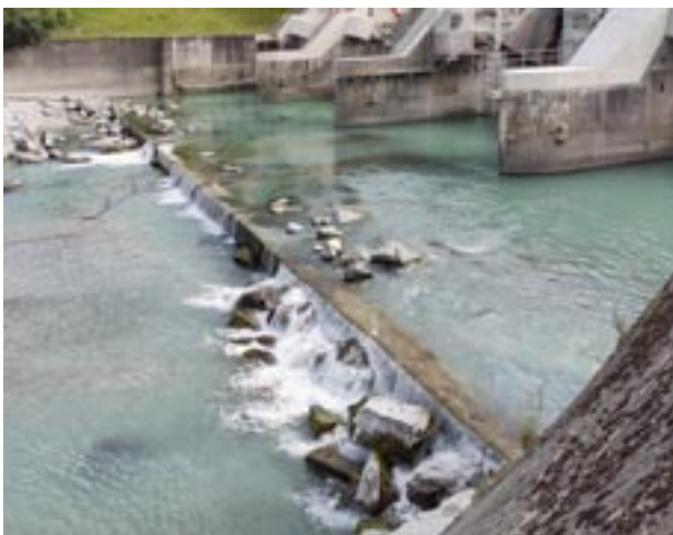
Situazione della centrale di Reichenau a settembre 2021.
