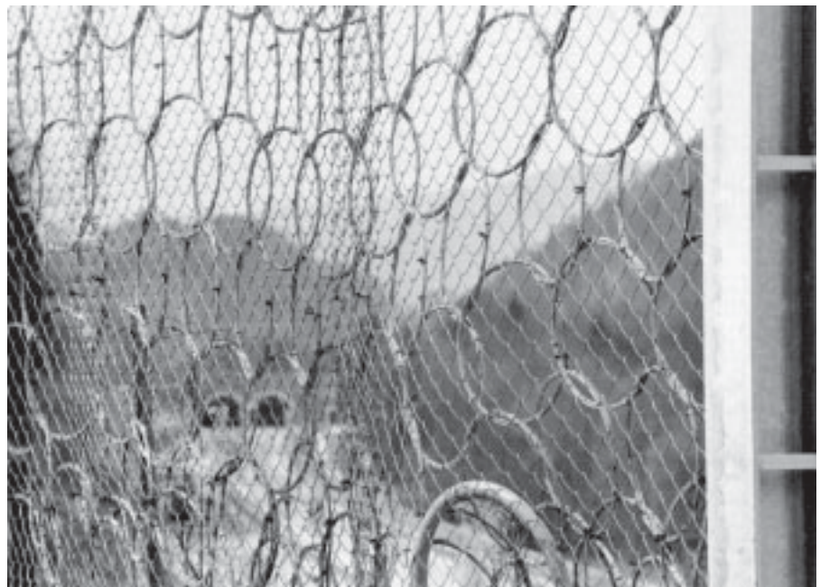
Kellerhals + Haefeli AG, Steinschlagnetz
