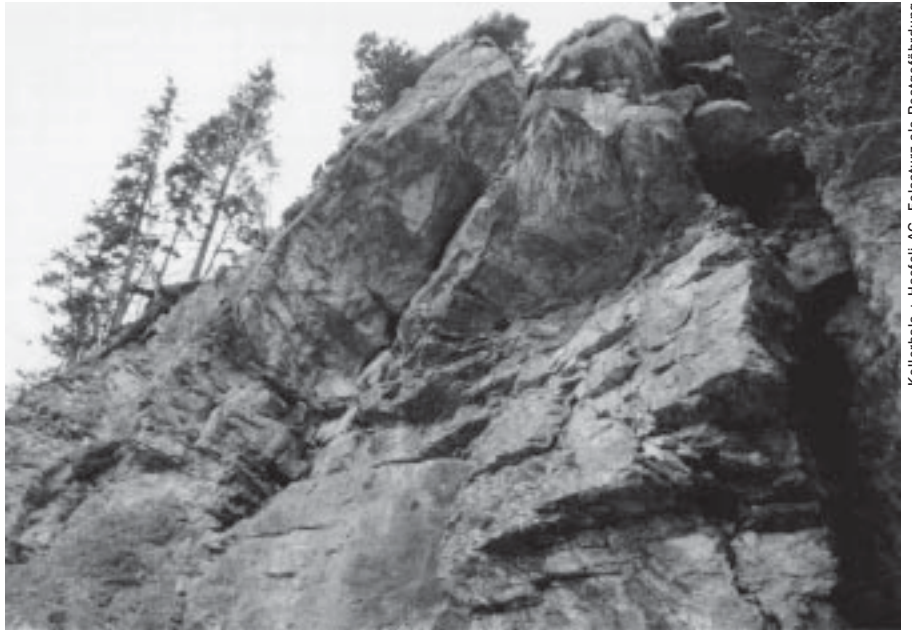
Kellerhals + Haefeli AG, Felssturz als Restgefährdung
