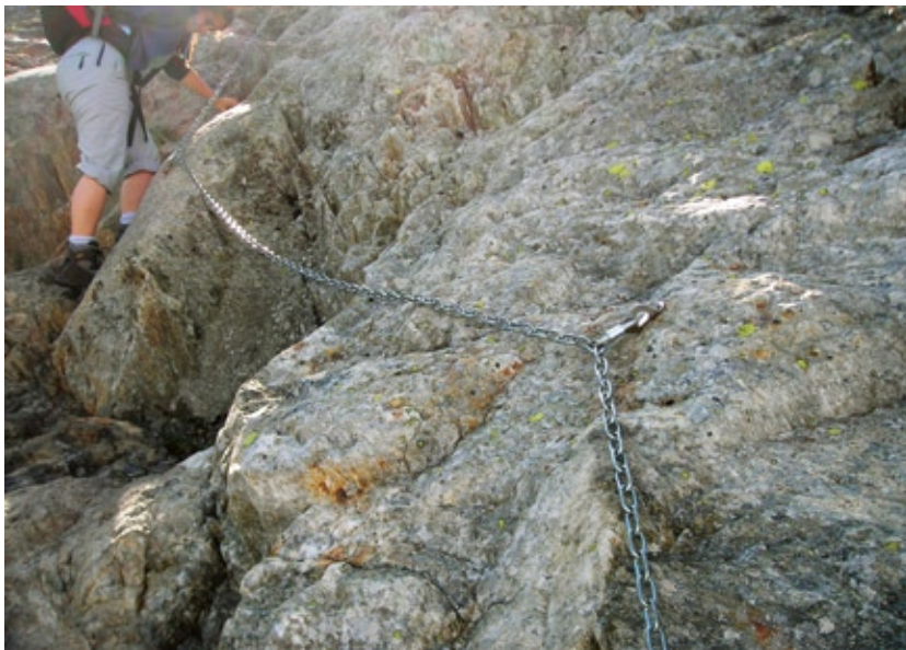
Abb. 63 Handlauf aus verzinkter Kette
