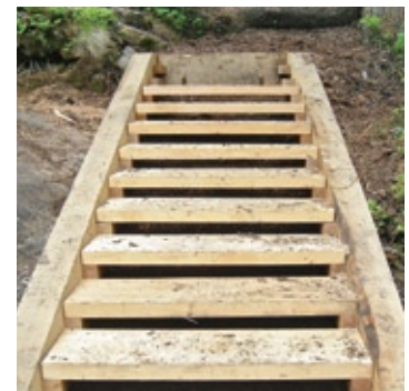
Abb. 59 Frei gespannte Treppe
