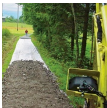
Abb. 20 Der Einbau der Founda-tionsschicht erfolgt vor Kopf.
