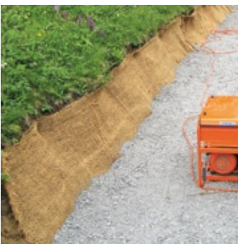
Abb. 76 Bahnen aus Jute schützen die Böschung während der Bauarbeiten vor Erosion.
