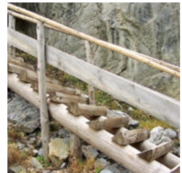
Abb. 58 Frei gespannte Treppe
