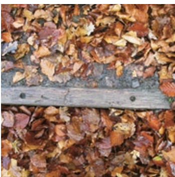
Abb. 56 Stufe mit Bohrlöchern für die Armierungseisen
