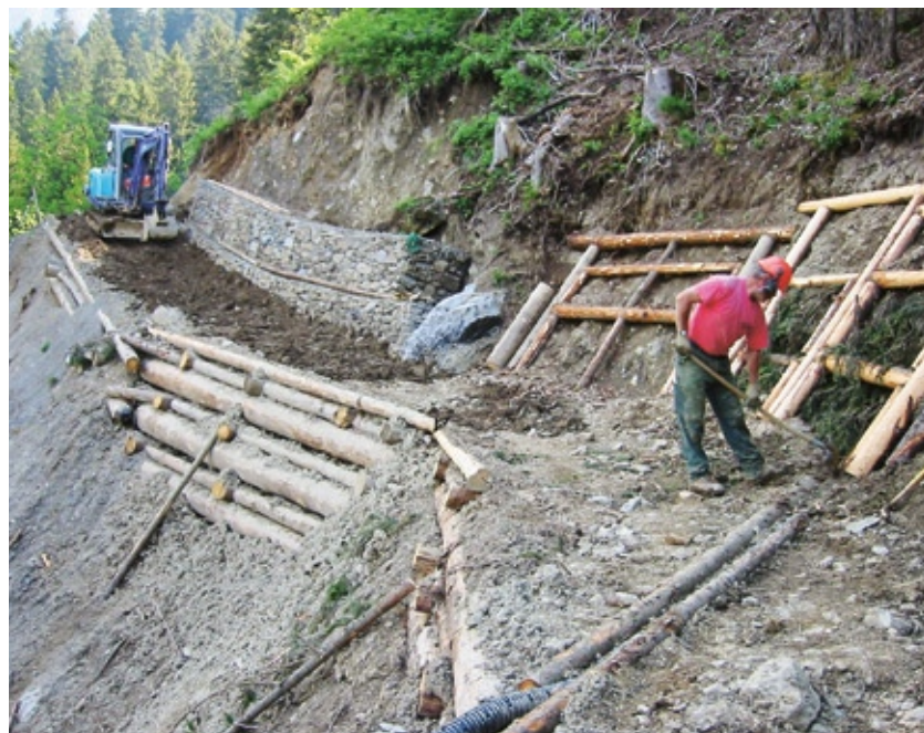
Abb. 81 Hangsicherung mit Holzkasten (links), Steinkörben (hinten) und Hangrost (rechts)
