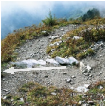
Abb. 26 Entwässerung im Wendepunkt
