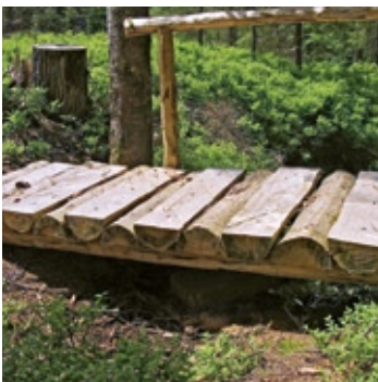
Abb. 50 Gehfläche aus halbierten Rundhölzern
