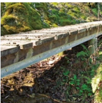
Abb. 51 Gehfläche aus sägerohem Holzblechern
