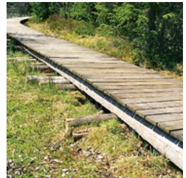
Abb. 53 Steg auf Querbalken
