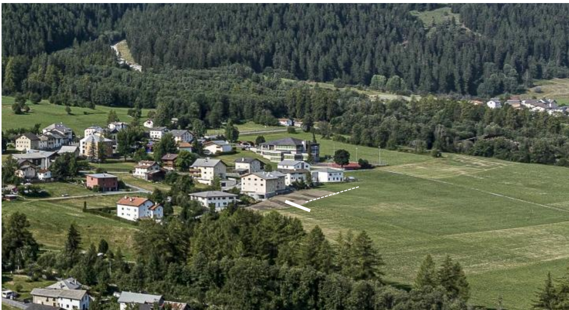
Abb. 16: Sicht auf Quartier Mundaditschas von Nordosten aus. Weisse Linie markiert ungefähren Standort des westlichen Tunnelportals, die weiss gestrichelte Linie den ungefähren Verlauf des oberirdischen Streckenteils.
