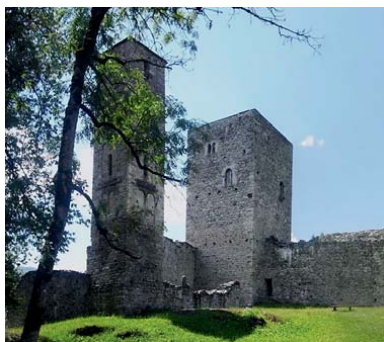
Die Burganlage Munt Sogn Gieri in Waltensburg/Vuorz soll kultureller Treffpunkt für Einheimische und ein Erlebnis für Gäste werden.
