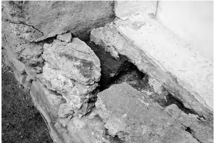
Abb. 35: Müstair, Kloster St. Johann. Westtrakt, Erdgeschoss, Kreuzgang 11w. Brüstungsmauer der südlichsten Kreuzgangarkade, Reste der jüngeren Aufmauerung, dahinter Erdreich mit Mörtelabdeckung und Aussparung für ein Schwellenholz. Blick gegen Südosten.
