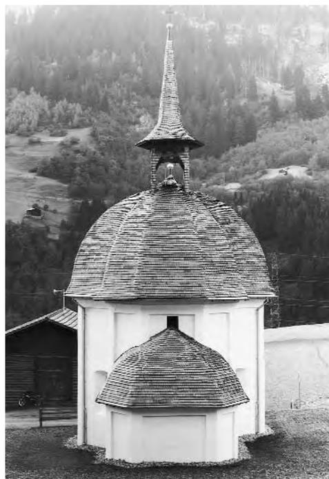
Fichtenholz gespalten werden und gar über 100 Jahre, wenn Lärchenholz zum Einsatz kommt.<sup>192</sup> Zum Vergleich: Die Materialgarantie für Eternit beträgt ganze zehn Jahre! Voraussetzung für die Langlebigkeit eines Holzschindeldaches ist, dass bei der Wahl des Holzes und dessen Aufbereitung gewisse Grundregeln beachtet werden.
