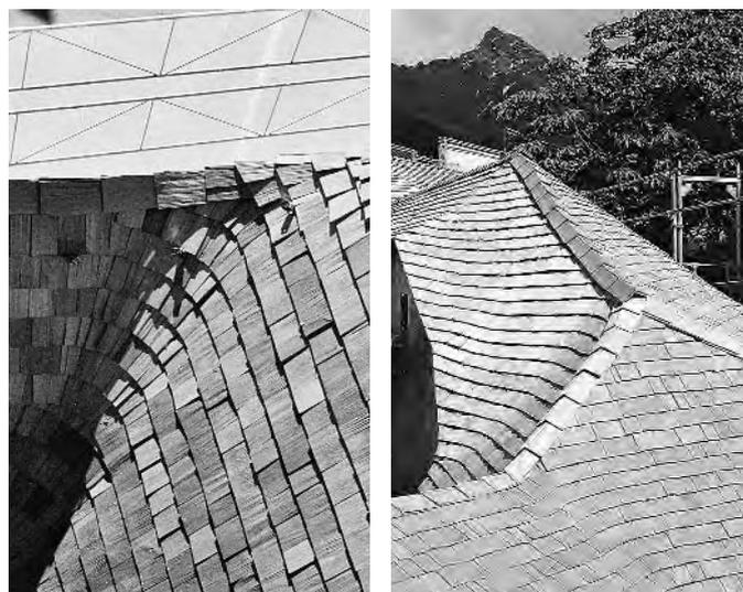
Abb. 92: Bever, evangelisch-protestantische Kirche. Schindeldach, Kehl- und Gratabbildung (links); Tarasp, Schloss Tarasp. Schindeldach Wehrgang, First- und Gratabschluss (rechts).
