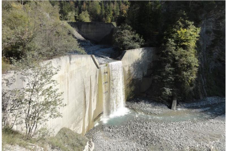
Bild 5: Konsolidationssperren am Schraubbach.
