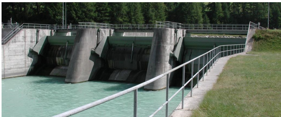
Bild 2: Beispiel eines Stauwehrs am Inn bei S-Chanf, Blick von der Unterwasserseite.
