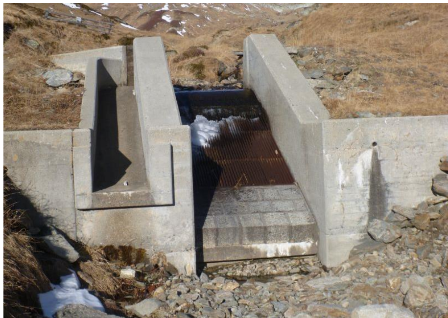
Bild 1: Beispiel eines Tirolerwehrs am Oberalpassbach.
