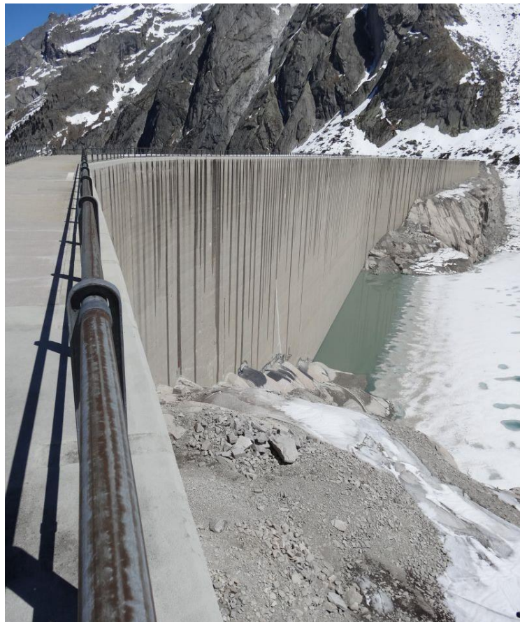
Bild 3: Staumauer Albignia im Bergell.
