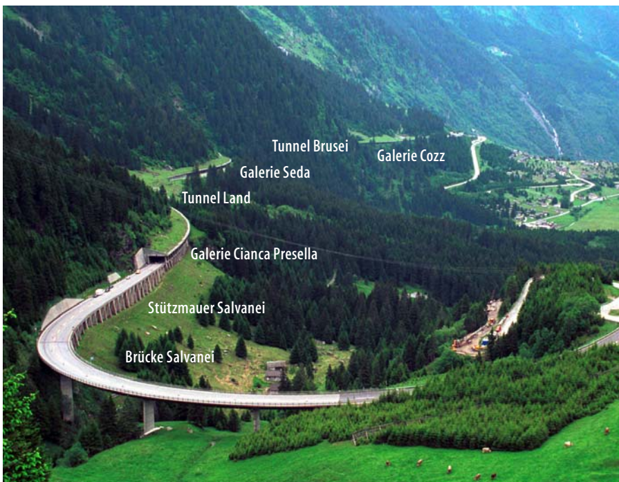
Blick auf den Instandsetzungsabschnitt
