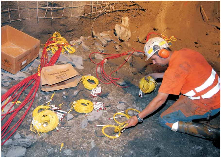
Bereitstellen der Zünder für die nächste Sprengetappe
