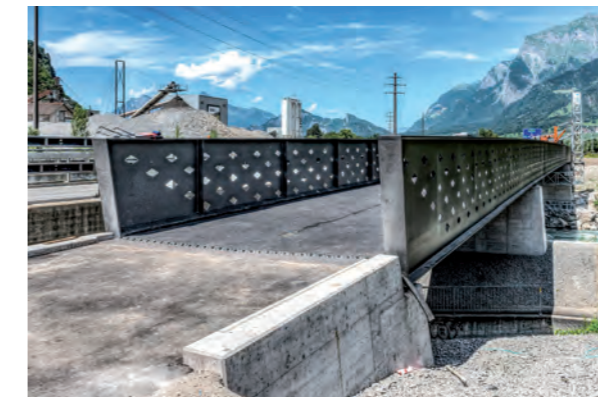
Abbildung 14: Beispiel einer Rad- und Fusswegbrücke über die Landquart
